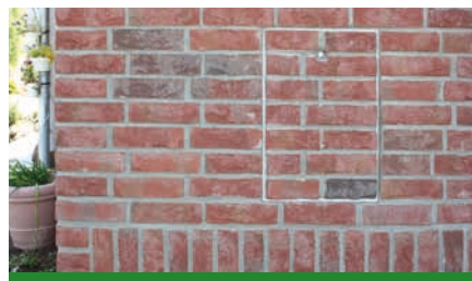
Außenwand-Hausanschlusskasten mit Stecktür für Riemchen
